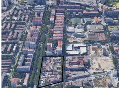
Protecció patrimonial «Casertes del Maresme»
