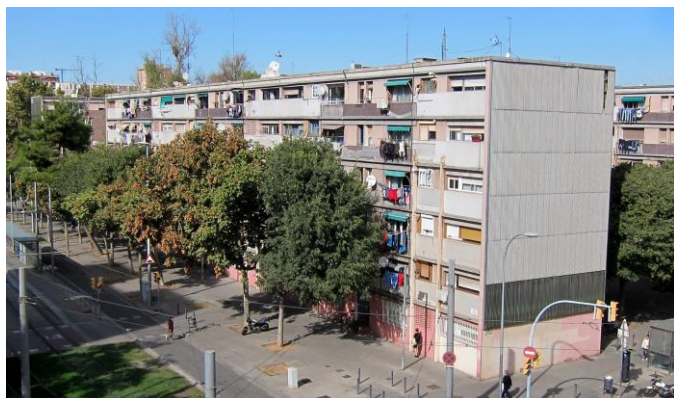
Vista parcial del bloque de viviendas. Se rehabilitará el portal que corresponde con el número 44
