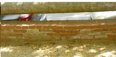
ABANS Deficient reparació d'un mur de la Rambla de Prim, 20
