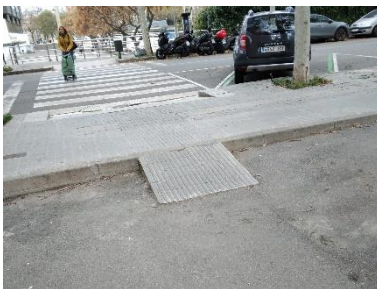
Rampa per salvar el pas de vianants del carrer Puigcerdà/Puja-des, camí del CEM Maresme
